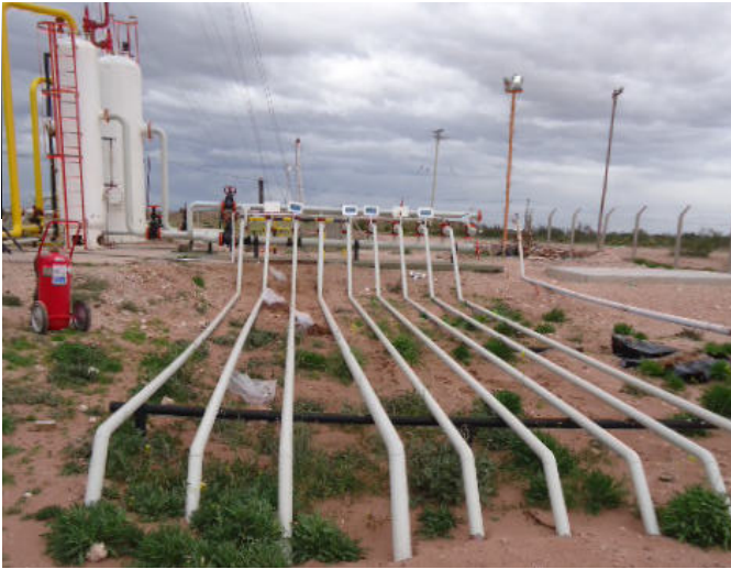
RELEVAMIENTO: CONTROL POST SANEAMIENTO DE UN DERRAME
