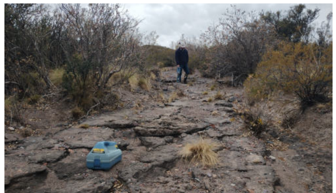
DELIMITACIÓN EN CAMPO DE INTERFERENCIA SOTERRADA
