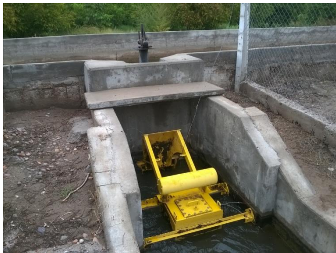
Figura 3 Compuerta de nivel constante (sin operar)
