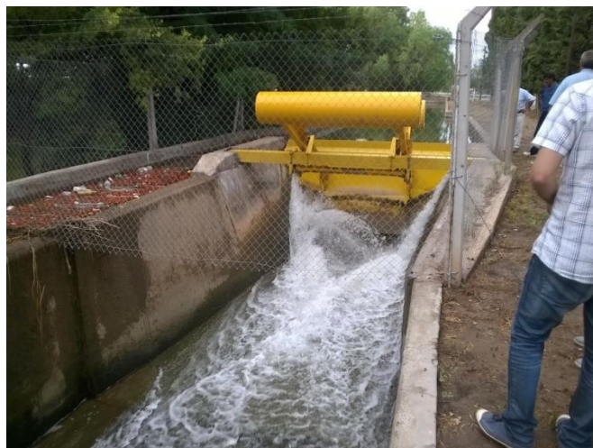
Figura 5 Compuerta de nivel constante aguas arriba (vista desde aguas abajo)
