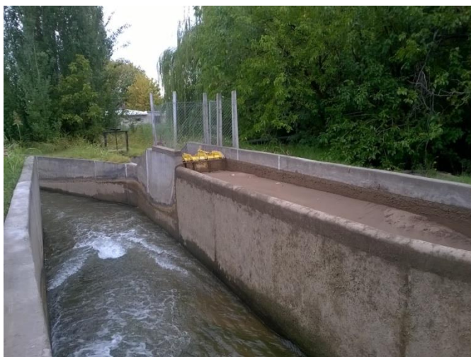
Figura 8 Vertedero lateral y módulos de doble máscara (vista desde aguas arriba)
