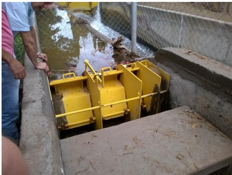
Figura 6 Módulos de doble máscara (vista desde aguas abajo)
