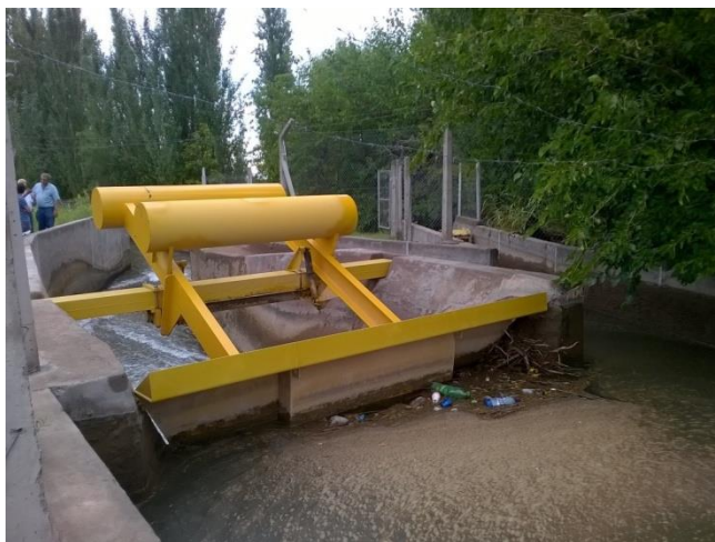
Figura 7 Compuerta de nivel constante (vista desde aguas arriba)
