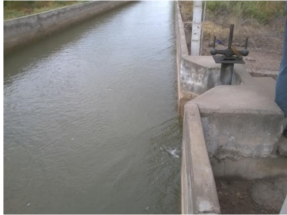
Figura 2 Compuerta plana en cauce principal
